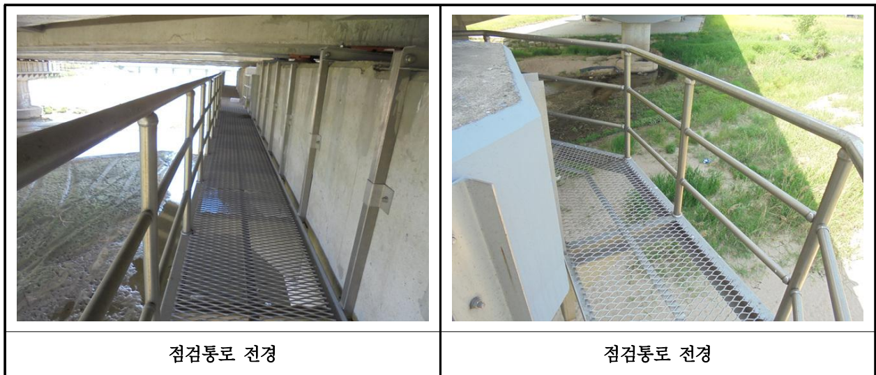
【사진 2.3.27】 교량 점검시설 전경
