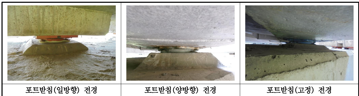
【사진 2.3.14】 교량받침 전경
