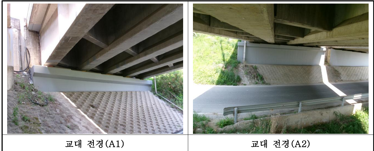
【사진 2.3.8】 교대 전경
