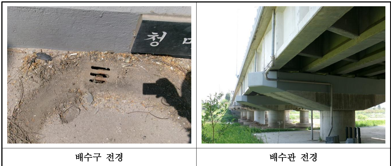
【사진 2.3.23】 배수시설 전경
