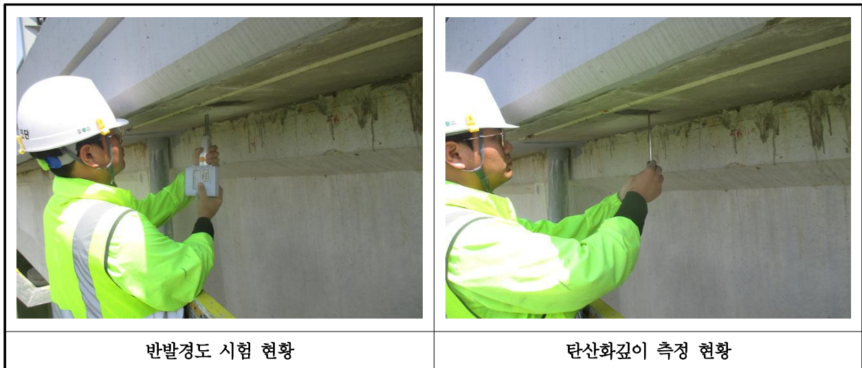
【사진 2.4.1】 콘크리트 내구성조사 현황
