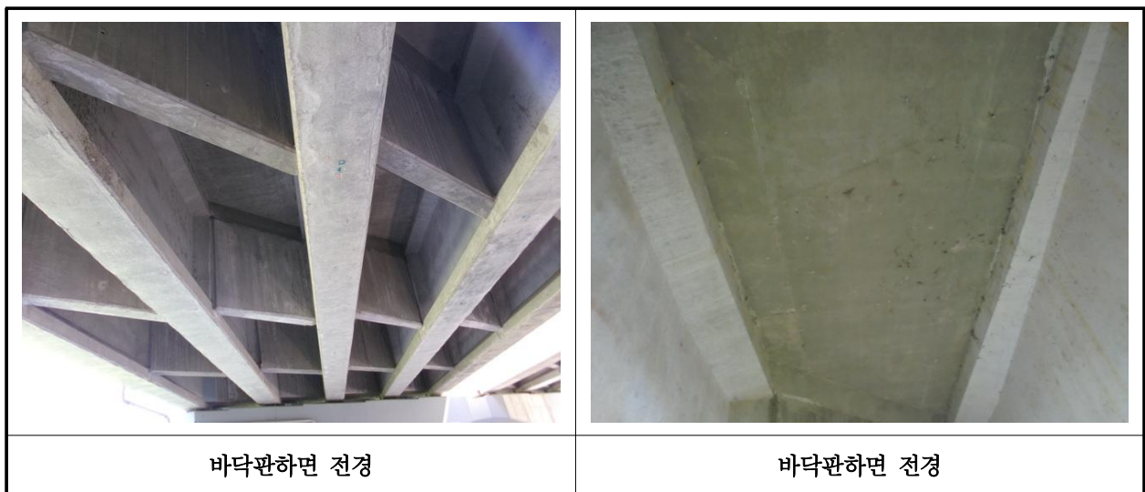
【사진 2.3.2】 바닥판하면 전경
