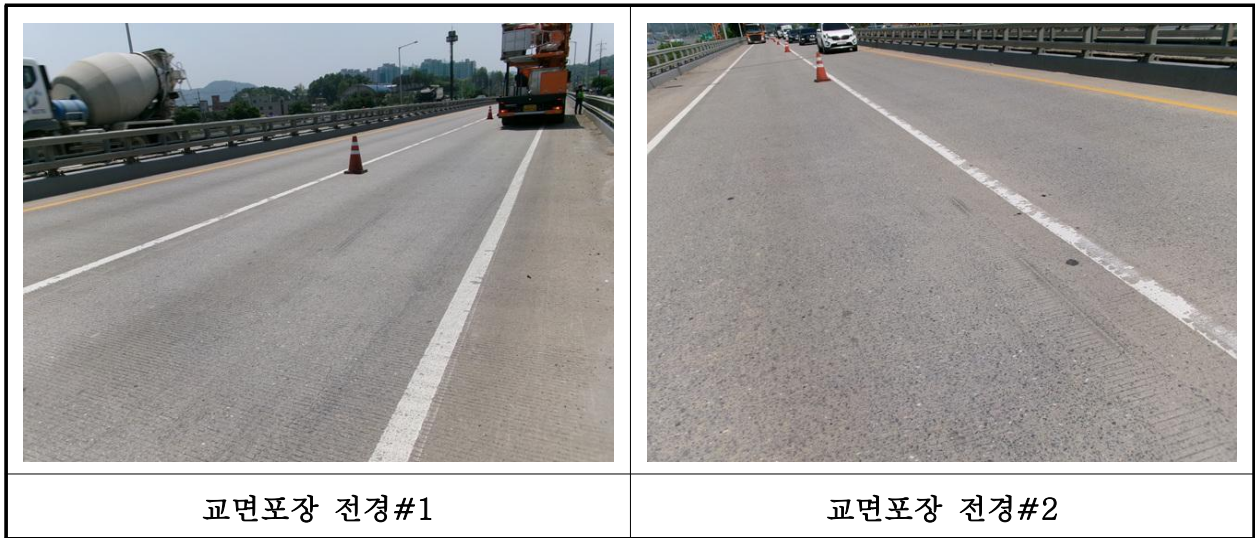
【사진 2.3.21】 교면포장 전경
