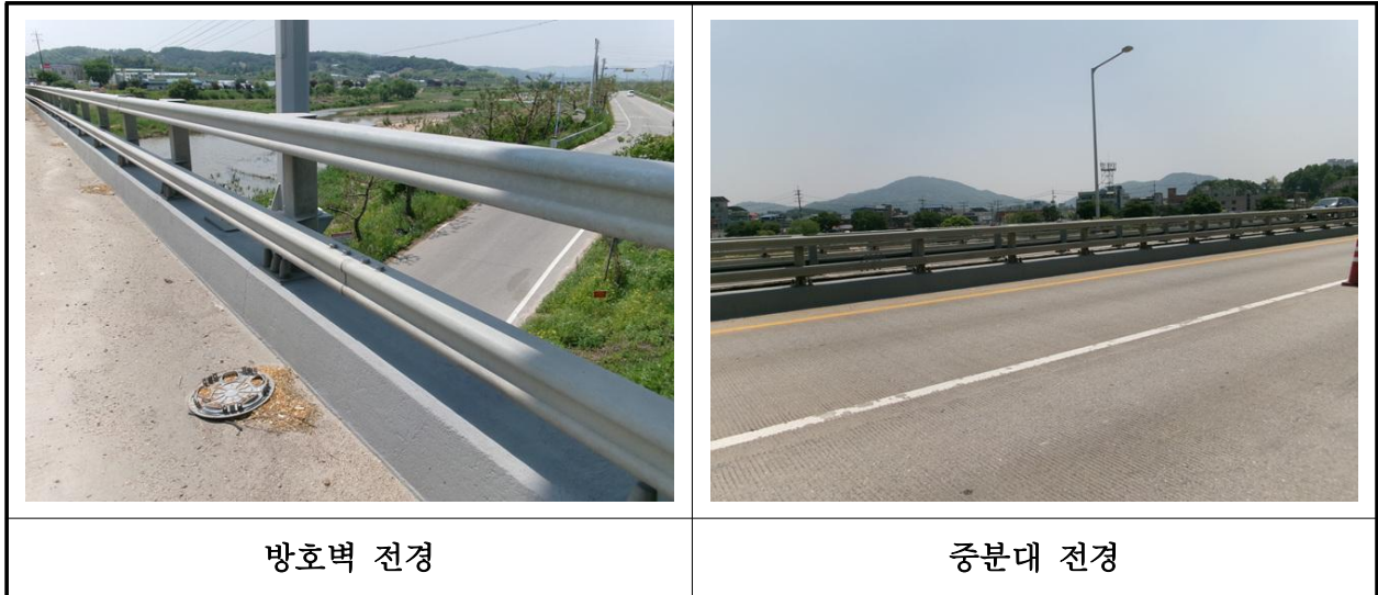
【사진 2.3.25】 방호벽 및 중앙분리대 전경
