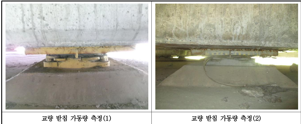
【사진 2.3.17】 교량받침 이동량 측정
