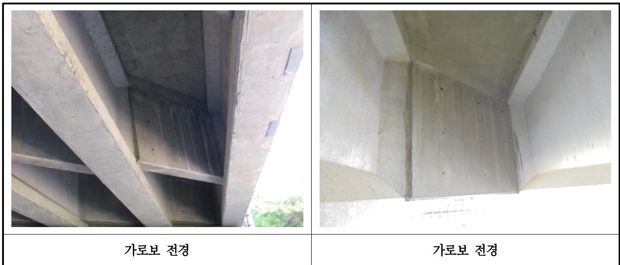
【사진 2.3.6】 가로보 전경
